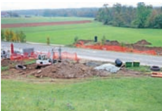
Gradnja prve faze kanalizacije v zgornjem delu Tupalič
