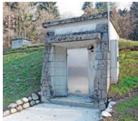
Vodovod Hraše-Ledevnica je strateškega pomena za preskrbo občine s pitno vodo. V okviru projekta je popolnoma prenovljen in z UV-dezinfekcijo opremljen tudi vodohran Ledevnica.
