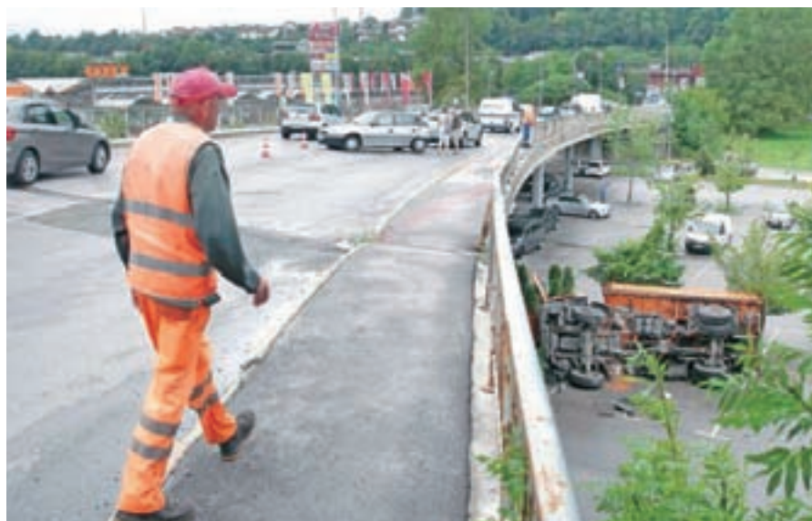
Na kranjski obvoznici je tovornjak pebil ograjo in padel na parkirišče pod mostom.
